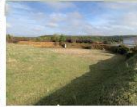
Vue sur l'Intérieur du merlon courbe
