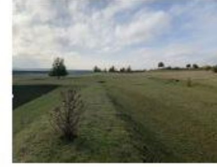
Vue sur le merlon principal
