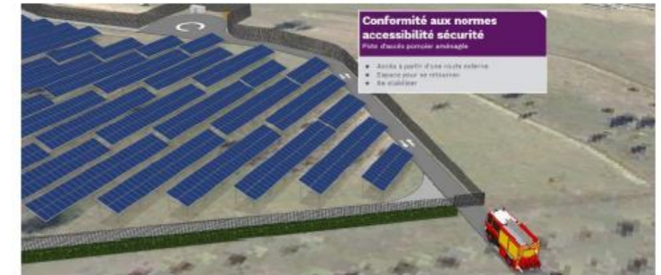
Figure 19 - Accessibilité de la centrale
