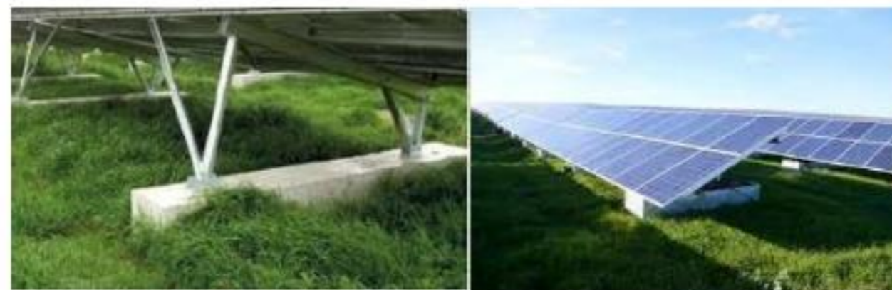
Figure 25 - Longrines et gabions pour parc au sol photovoltaïque
